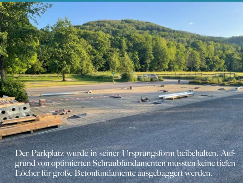
Der Parkplatz wurde in seiner Ursprungsform beibehalten. Aufgrund von optimierten Schraubfundamenten mussten keine tiefen Löcher für große Betonfundamente ausgebaggert werden.
