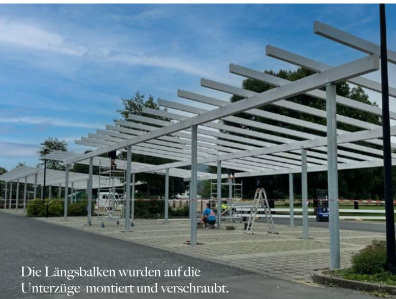
Die Längsbalken wurden auf die Unterzüge montiert und verschraubt.
