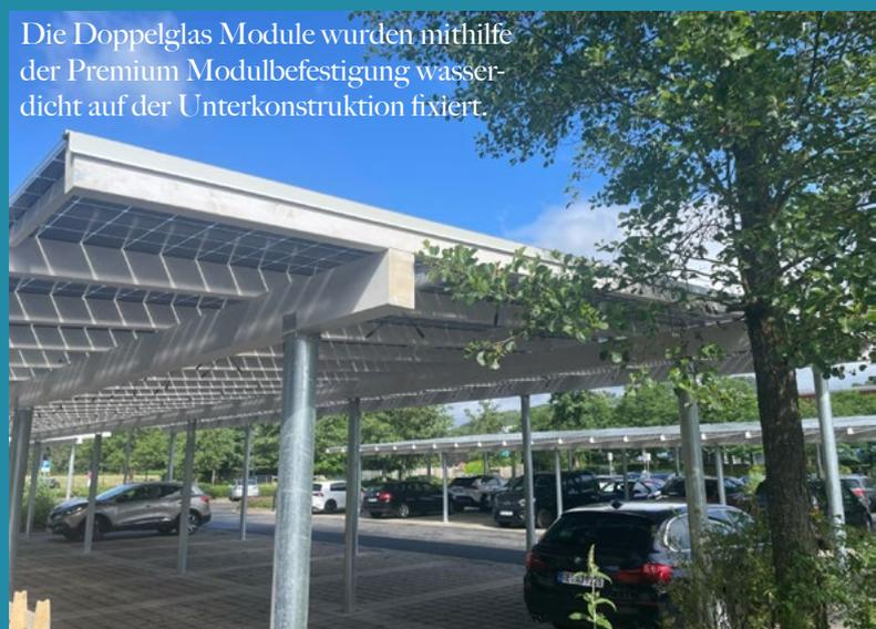
Die Doppelglas Module wurden mithilfe der Premium Modulbefestigung wasserdicht auf der Unterkonstruktion fixiert.
