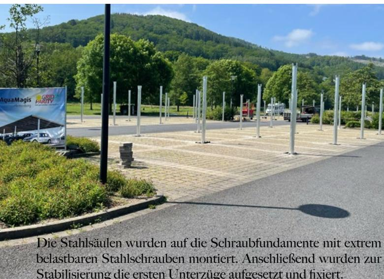
Die Stahlsäulen wurden auf die Schraubfundamente mit extrem belastbaren Stahlschrauben montiert. Anschließend wurden zur Stabilisierung die ersten Unterzüge aufgesetzt und fixiert.
