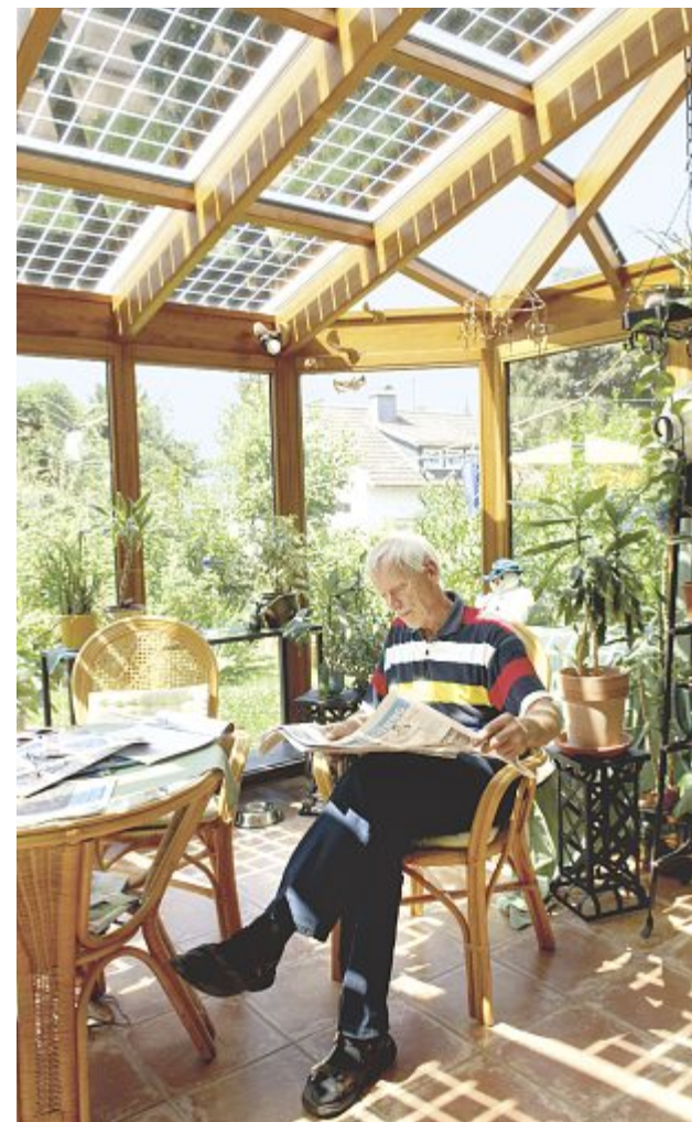
Die Photovoltaik-Zellen im Wintergartendach ersparen einen Sonnenschutz.
